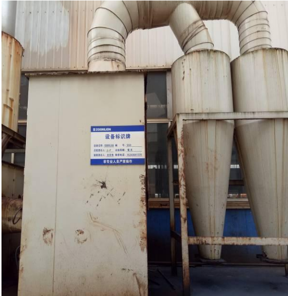
下料车间旋风除尘器
