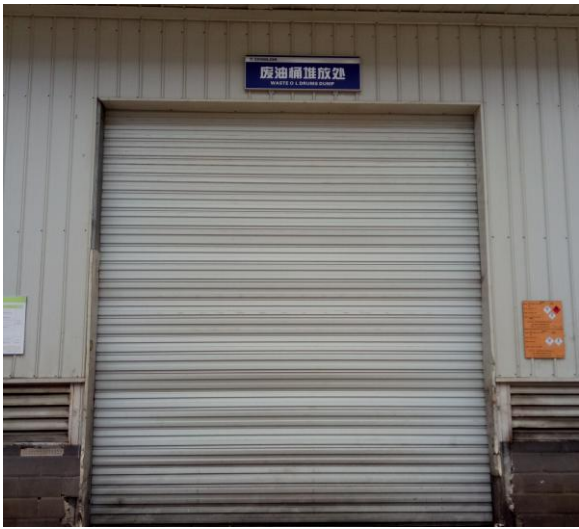
废油桶暂存间
